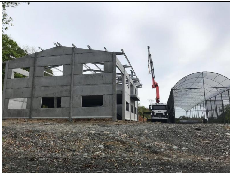
Foto 16: Estágio da construção da estufa e galpão até o dia 11/10/2018.
