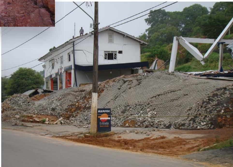
4) **Quedas** são movimentos de blocos rochosos de formas variadas que se desprendem da encosta e caem ou se movem sobre um plano inclinado com elevada velocidade (em metros/segundo). Esses movimentos podem ser queda, rolamento ou tombamento de matações (figuras 16 e 17), e foram pouco frequentes no desastre de 2008.
