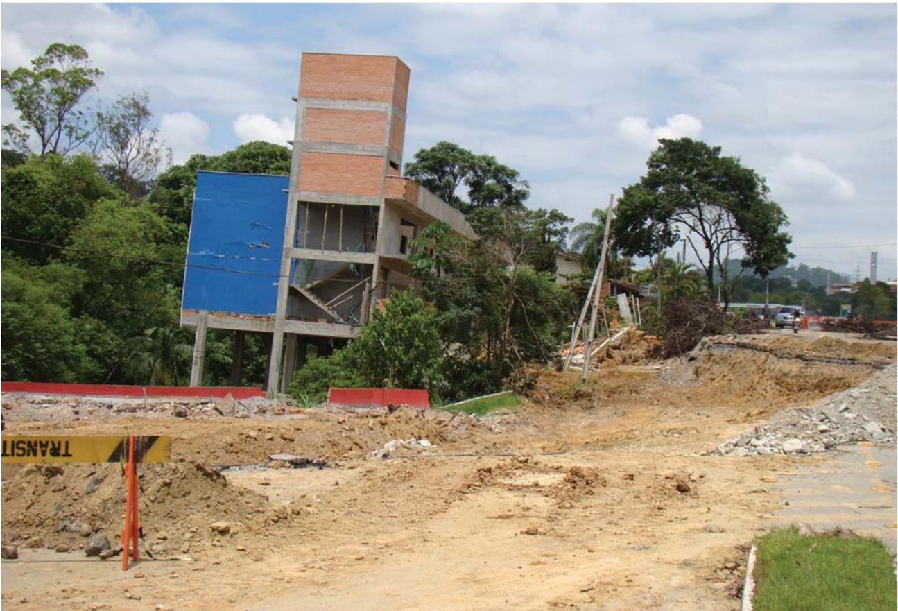
Figura 20: Aterro pouco adensado sob rodovia Br. 470, e construção em área de preservação permanente, Badenfurt, Blumenau, dezembro de 2008.
