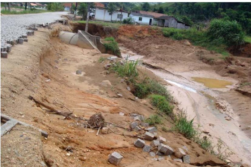
Figura 6: Dano causado pelo represamento da água na entrada de galeria no Belchior, em Gaspar, no desastre de novembro de 2008.
