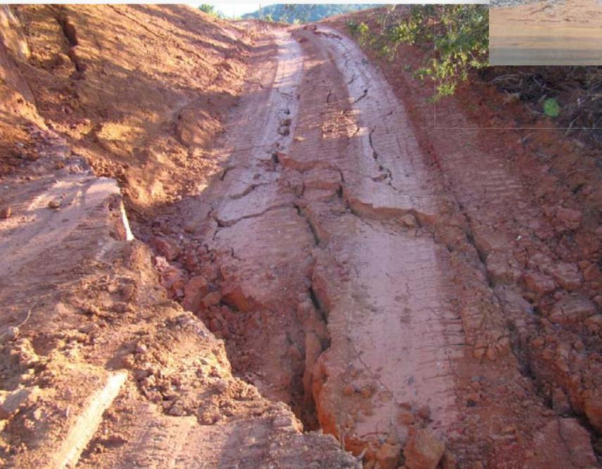
Figura 11. Fendas em escorregamento circular (rotacional), julho de 2009.
