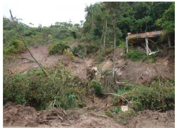
Figura 22: Tubulação de águas servidas em residência induzindo escorregamento circular, Rua Itajaí, Blumenau, novembro de 2008. Fotos: Juarês J. Aumond.
