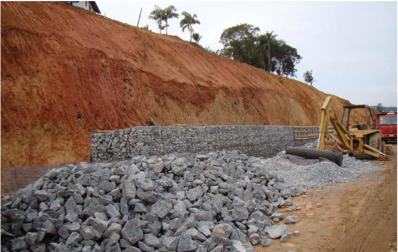
Figura 13: Muro gabião em construção na rodovia expressa, Blumenau.
