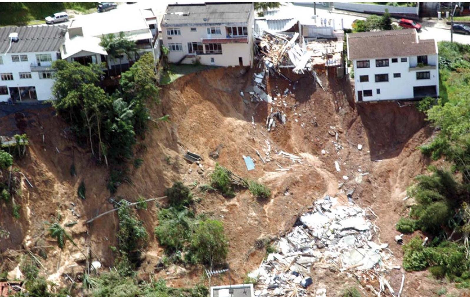
A ocupação de áreas de risco de deslizamento, com edificações precárias, em sistema de autoconstrução, sem drenagem e com remoção da vegetação, tornou-se endêmica em Blumenau (Figura 10), e tem resultado em catástrofes periódicas nos períodos de maior precipitação (Figura 11). Em 1990, 22 pessoas perderam a vida, soterradas.
