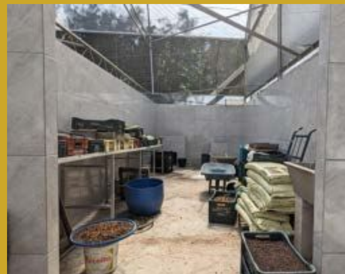
Modernização das estruturas do Viveiro
