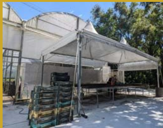
Obras de melhoria no Viveiro
